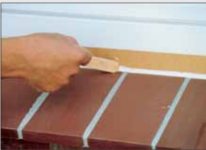
Der UNIFLEX-PU-Strang kann nach kurzer Anhärtezeit mit einem nassen Werkzeug (Spachtel oder Finger mit Schutzhandschuh) an der Oberfläche nachgeformt werden, ohne dass die Masse aufreißt
